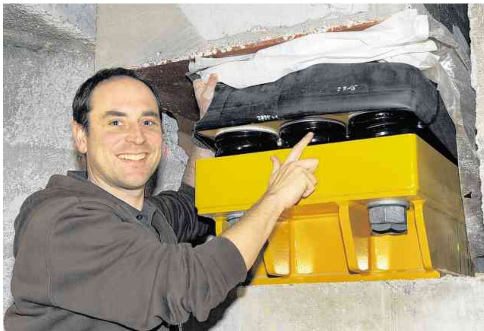
Harry Klein-Chef David Süß eröffnet im April seinen neuen Club. Anwohnerbeschwerden will er durch Federn vermeiden, die Lärm direkt ins Fundament leiten. Fotos: Gregor Feindt
